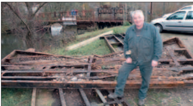
Igor Remetter sur les portes endommagées, pendant que ses ouvriers ajustent les nouvelles vannes (blanches, au fond).
