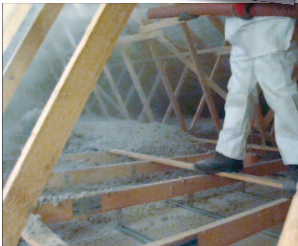
La ouate de cellulose est déposée dans la cardeuse (photo du haut, machine rouge), puis soufflée sous les combles.
