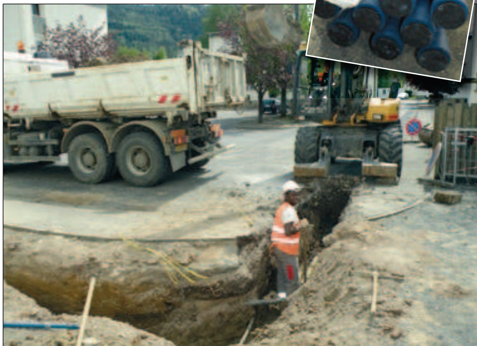
Au fond de la fouille, la nouvelle canalisation « blutop » relie tous les bâtiments du Toit Vosgien.
